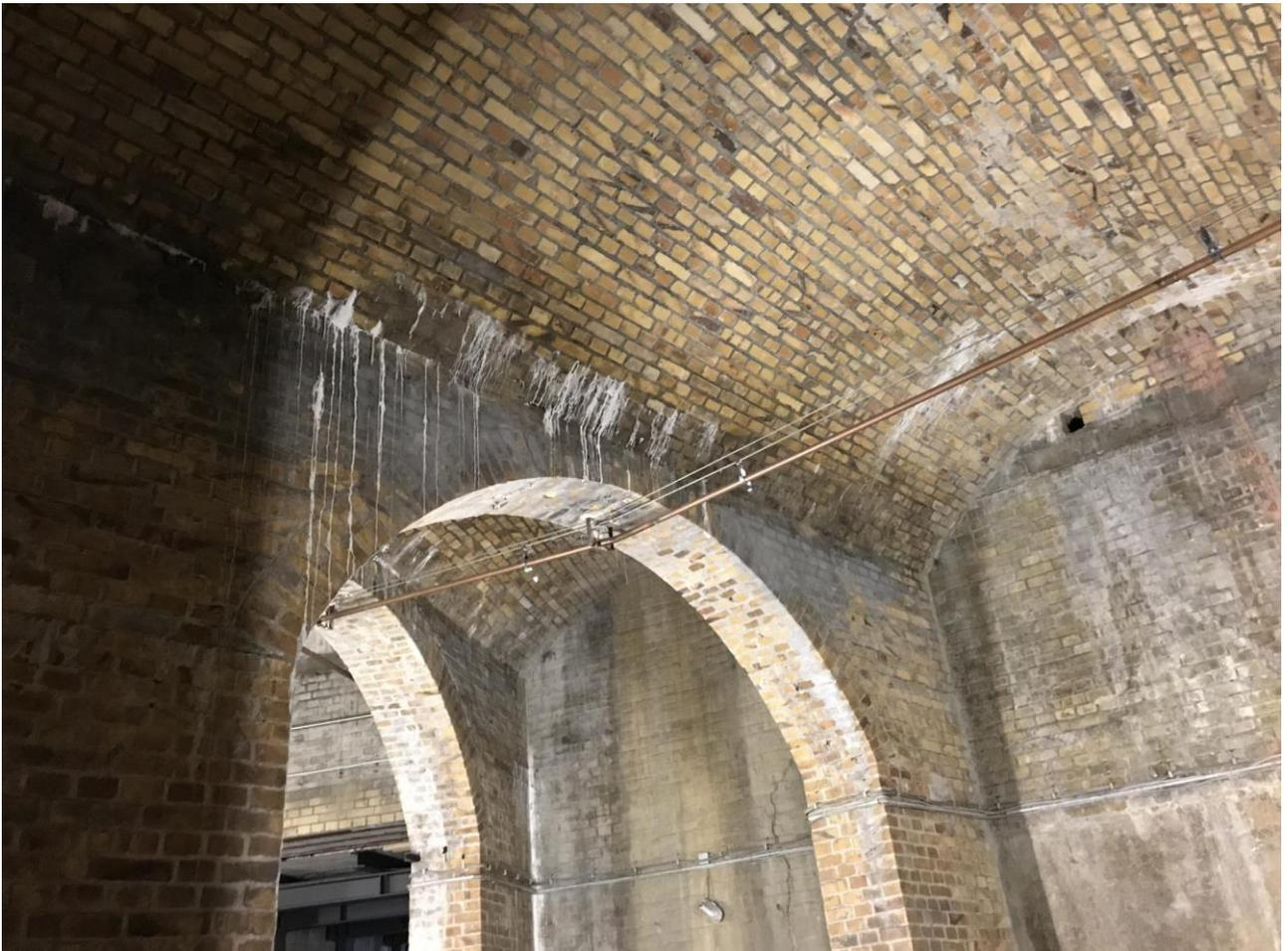
Traces du passé : sur les segments voûtés du réservoir, l'eau a déposé du sel.
