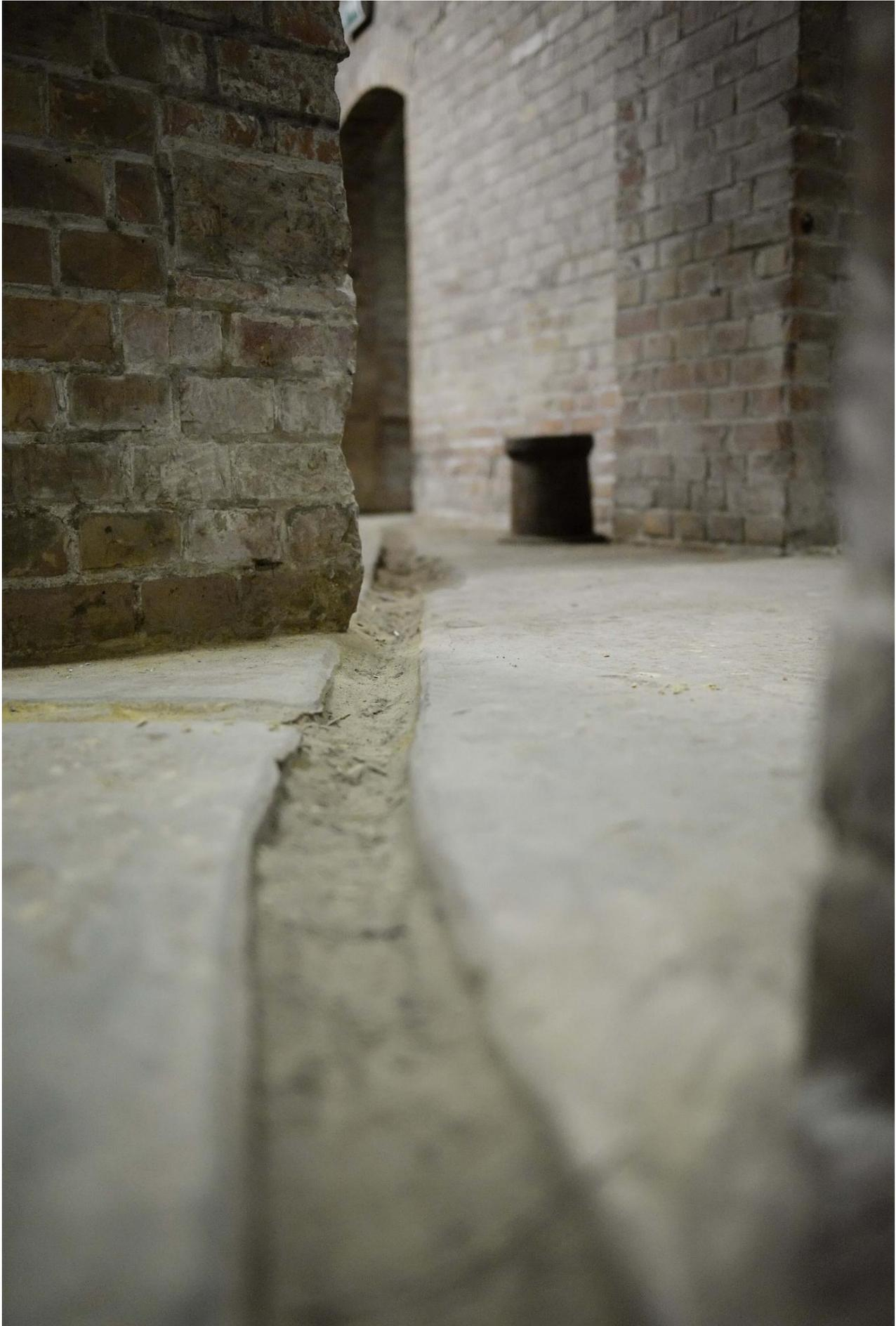
Des rigoles creusées dans le sol du réservoir témoignent de l'époque où c'était une poissonnerie. L'eau y coulait et permettait d'asperger les poissons.
